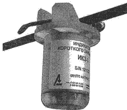
Рисунок 1 - Установка индикатора короткого замыкания ИКЗ-3 на провод ВЛ
